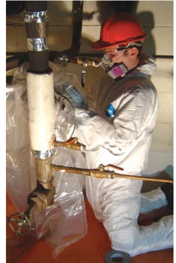
LINDSAY ASBESTOS ABATEMENT
